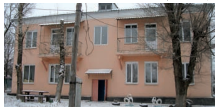
Один из жилых домов после капремонта
